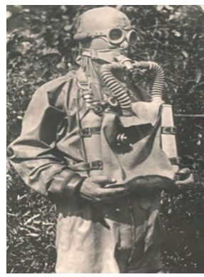
Изолирующий противогаз ИПА-2 Self-contained respirator ИПА-2
