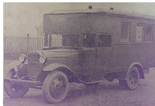
Рисунок 3 – Химическая автолаборатория АЛ-2 (фотография из архива ФГКВУВО «ВА РХБ защиты» Минобороны России)
