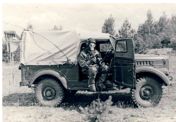
Рисунок 5 – Боевая химическая разведывательная машина ГАЗ-69рх (фотография из архива ФГКВООУО «ВА РХБ защиты» Минобороны России)
