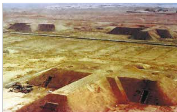
Рисунок 5 – Бункеры временного хранения химического оружия в Самарре [19] (Полуподземные сооружения, напоминают усеченную пирамиду. Основное хранилище заглублено на 5 м ниже уровня земли, размеры – 60х18х10 м. Стены и крыша сооружения из железобетона толщиной 1 м. Кровельная плита была покрыта трехметровым слоем песчаной глины. Каждый бункер имел два боковых входа, которые позволяли персоналу добраться до основной камеры. Основное хранилище было защищено от внешних взрывов усиленными дверями. Имелись аварийный генератор, топливный бак, компрессор и охлаждающий блок)
