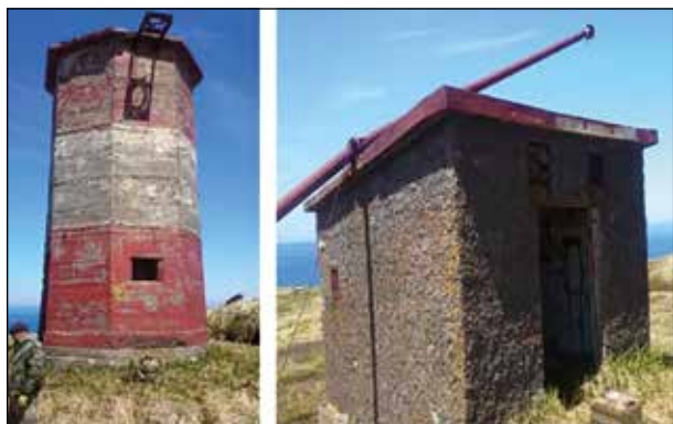
Рисунок 19 — Маяк и подсобное помещение
