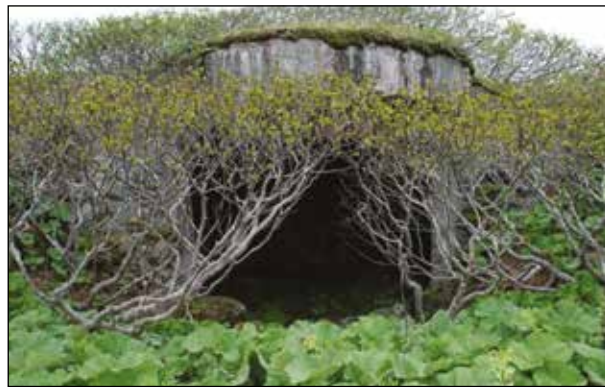
Рисунок 6 — Железобетонное укрытие для техники
