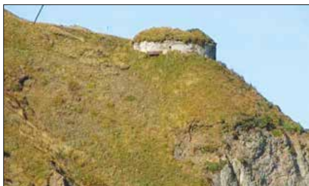
Рисунок 12 — Береговое бетонное укрытие для 7,7-мм легкого пулемета
