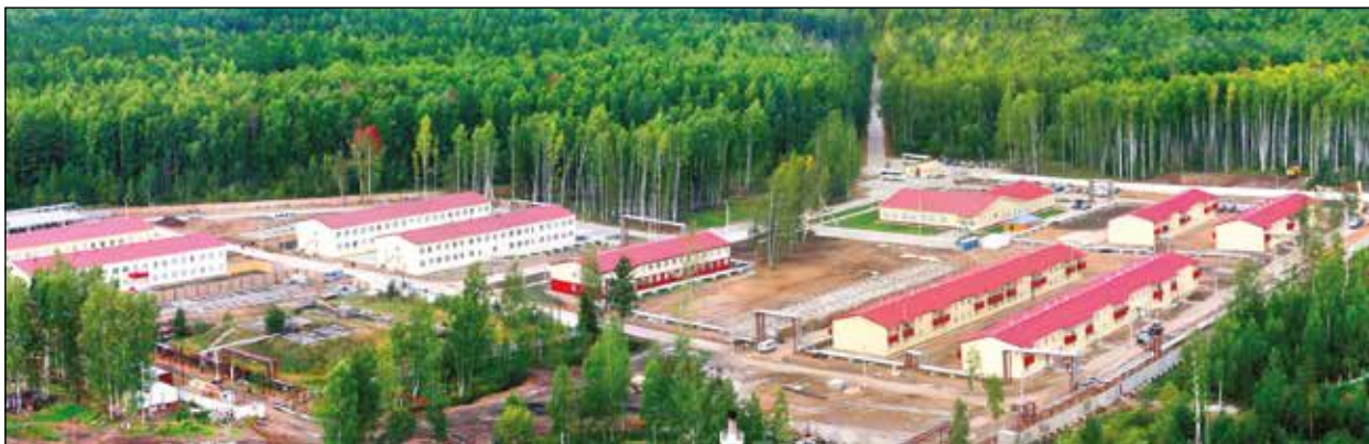
Рисунок 2 — Строительство вахтового городка 1
