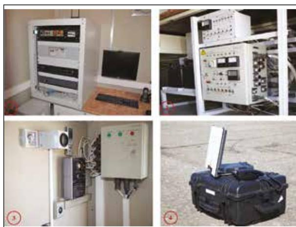
**Рисунок 13** — Оснащение модуля МОИ (1 – Автоматизированное рабочее место начальника модуля МОИ. 2 – Блок управления электропотребителями. 3 – Кабельный ввод, пульт управления климатической установкой. 4 – Станция спутниковой связи Инмарсат BGAN Explorer 700)
