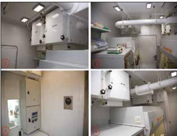
**Рисунок 6** — Система вентиляции модуля МИФА для обеспечения безопасности при проведении работ с патогенными биологическими агентами (1 – HEPA фильтры. 2 – Приточная вентиляция. 3 – Пульт управления системой вентиляции, отопления и кондиционирования. 4 – Вытяжная вентиляция)
