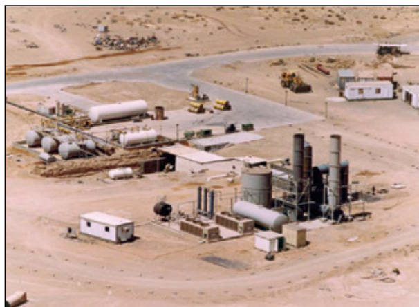
Рисунок 11 – Завод по сжиганию жидкого (неполимеризованного) сернистого иприта в аль-Мутанне. Максимальная производительность – 1,5 т/сут иприта [5]
