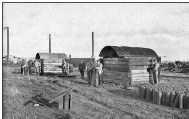
Рисунок 1 – Объект УХО образца начала XX века. Верден, 1919 г. Расснаряжение проводилось в деревянных бараках (в центре). На переднем плане – расснаряженные боеприпасы со снятыми взрывателями. На заднем плане – печи для сжигания уприта. Источник - GEKA [28]
