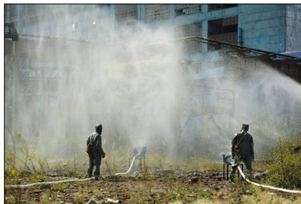
Рисунок 10 – Вспомогательный стол и выставленная с его помощью щелочная завеса (октябрь 2020 г., фотографии авторов)
