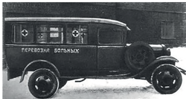
Рисунок 4 – Санитарная машина на базе «Форд-АА» – один из первых образцов ВВТ, оборудованный средством коллективной защиты от ОВ (фотография из архива 33 ЦНИИИ МО РФ)
