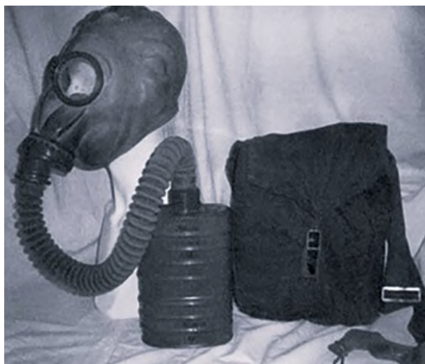
Рисунок 11 – Фильтрующий противогаз МО-2, 1942 г. (фотография из архива 33 ЦНИИИ МО РФ)
