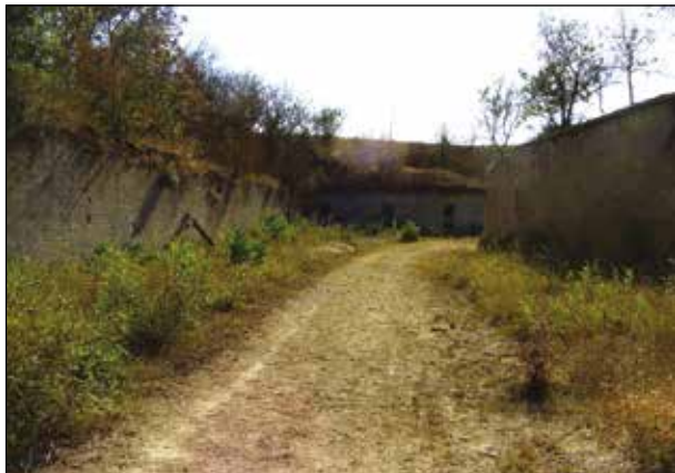
Рисунок 1 – Сухой ров Керченской крепости. Расположен ломаной линией по ее окружности. Повороты рва делят его на отдельные прямые участки и позволяют простреливать, «фланкировать» их из капониров, стоящих в углах рва. На фотографии – контрэскарп справа. По замыслу М.А. Зигерн-Корна, у основания контрэскарпа должны быть расположены управляемые из единого командного центра форсунки, распыляющие пылающий керосин. В этом случае сухой ров превращался для солдат противника в пылающую ловушку. Фотография М.В. Супотницкого
