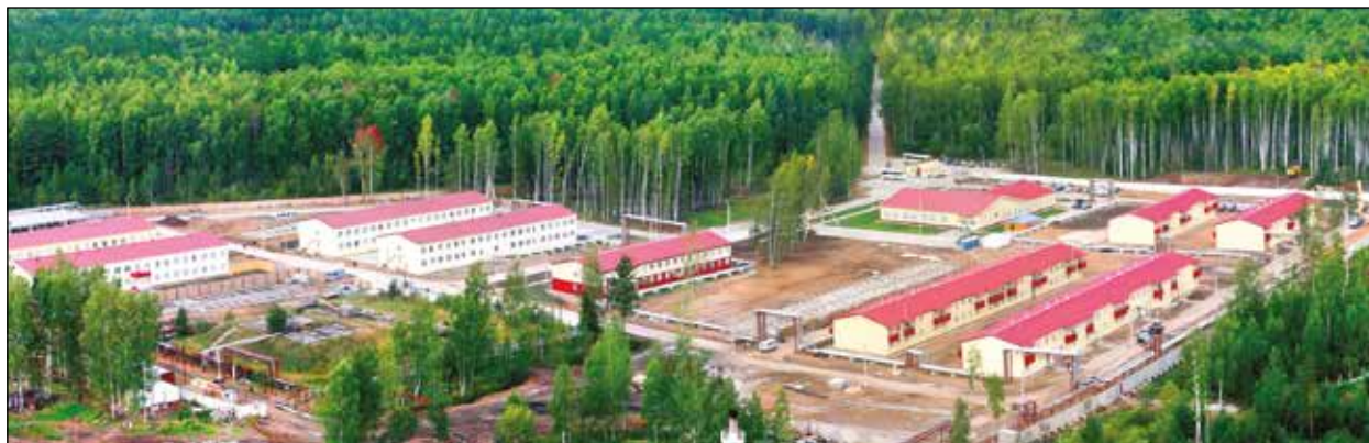
Рисунок 2 — Строительство вахтового городка 1
