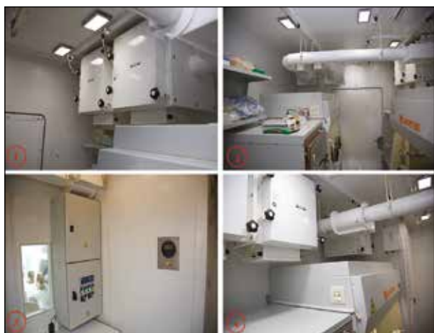
Рисунок 6 — Система вентиляции модуля МИФА для обеспечения безопасности при проведении работ с патогенными биологическими агентами
