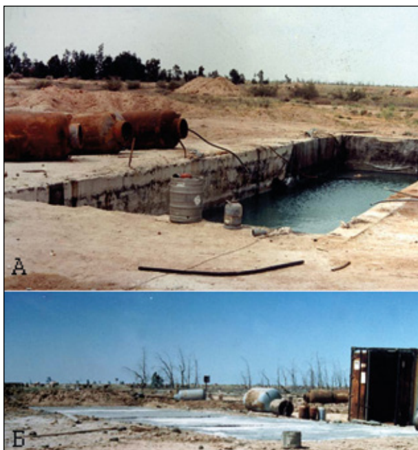
Рисунок 22 – Уничтожение тионилхлорида. (А. Лагуна тионилхлорида во время операции нейтрализации. Б. Она же после высыхания воды и герметизации бетоном [5])
