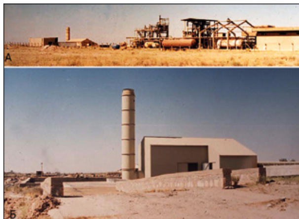
Рисунок 14 – Предприятие по уничтожению ФОВ в аль-Мутанне. (А. Общий вид гидролизного завода. Б. Гидролизный цех крупным планом [5])
